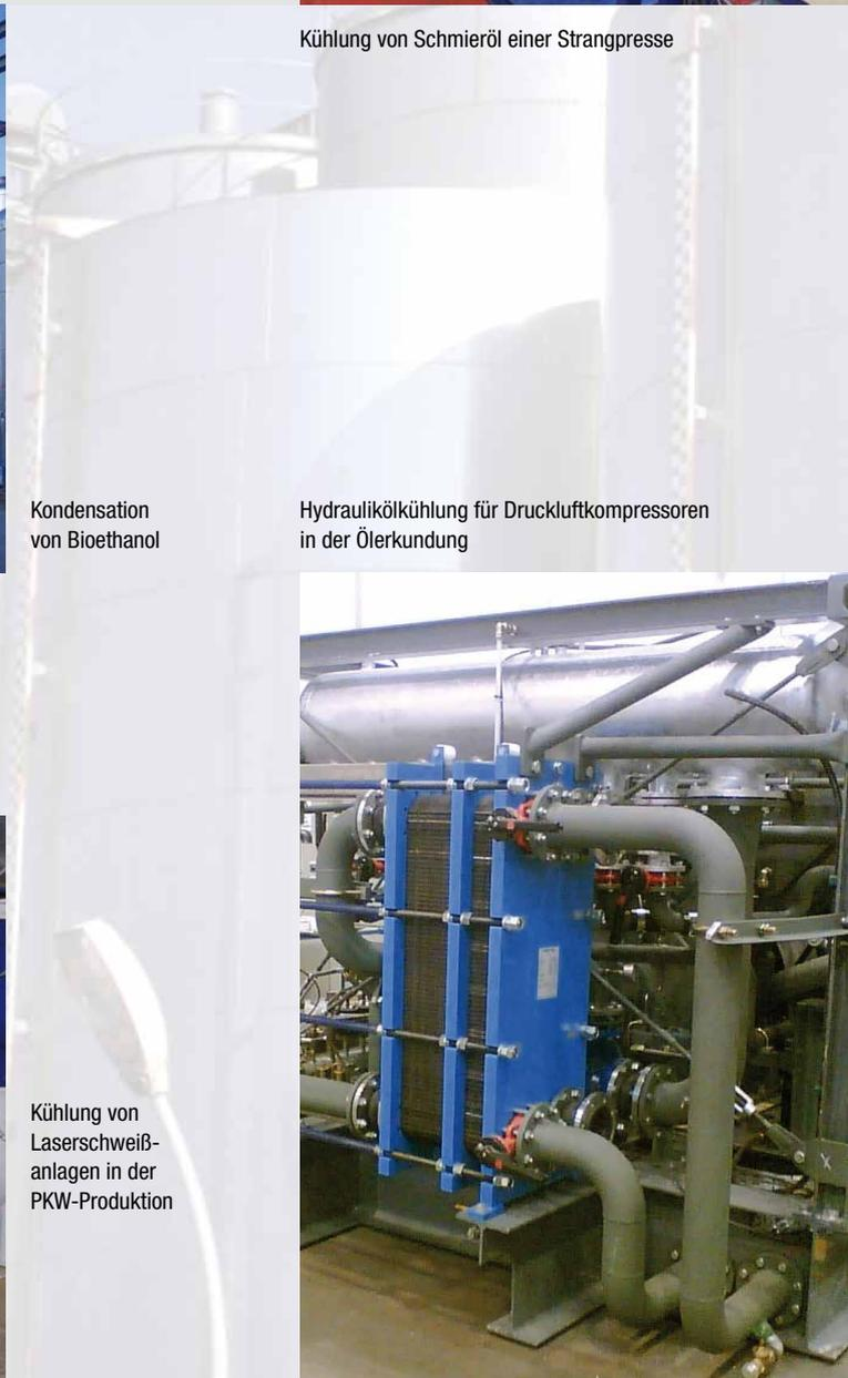
Hydraulikölkühlung für Druckluftkompressoren
