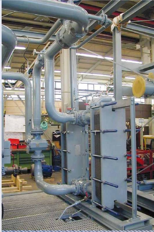
**Industrieanwendung – PWT im Bereich Heizung, Klima, Lüftung** (Beispiel: Fernwärmesystem)
